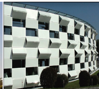
Figura 2: Fachada do Edifício Kiefer Technic Showroom
